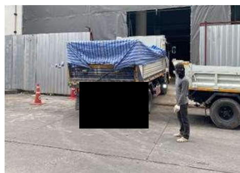
ภาพที่ 2.2-7 การปิดคลุมรถขนส่งวัสดุก่อสร้าง
