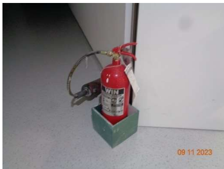
ภาพที่ 2.2-25 ถังดับเพลิงเคมี และป้ายแนะนำการใช้งาน
